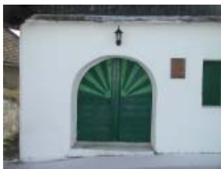
Abb. 10) sonnenförmiges Muster (Quelle: eigene Aufnahme)
