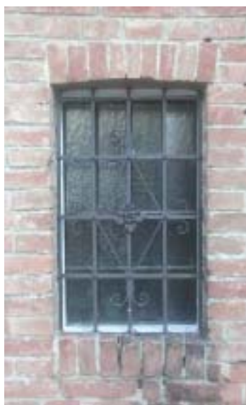
Abb. 24) Kellerfenster Redl-Keller (Quelle: eigene Aufnahme)
