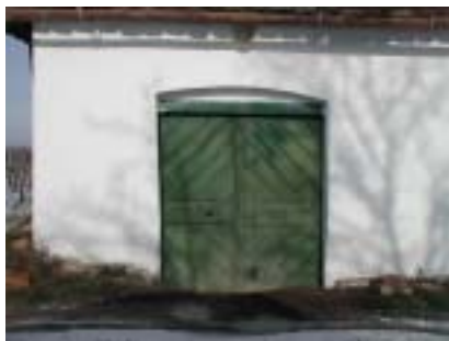
Abb. 4) Kellertür - geradlinig/diagonal (Quelle: eigene Aufnahme)
