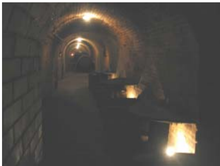
Abb. 23) Kellerröhre Redl-Keller (Quelle: eigene Aufnahme)
